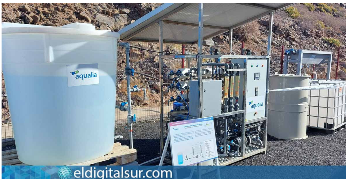
Módulos de desalinización del centro WAVE / EDS
